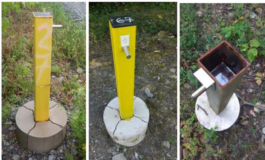
Obrázek 19 Popraskané betonové základy zajišťovacích značek ŽPSV
